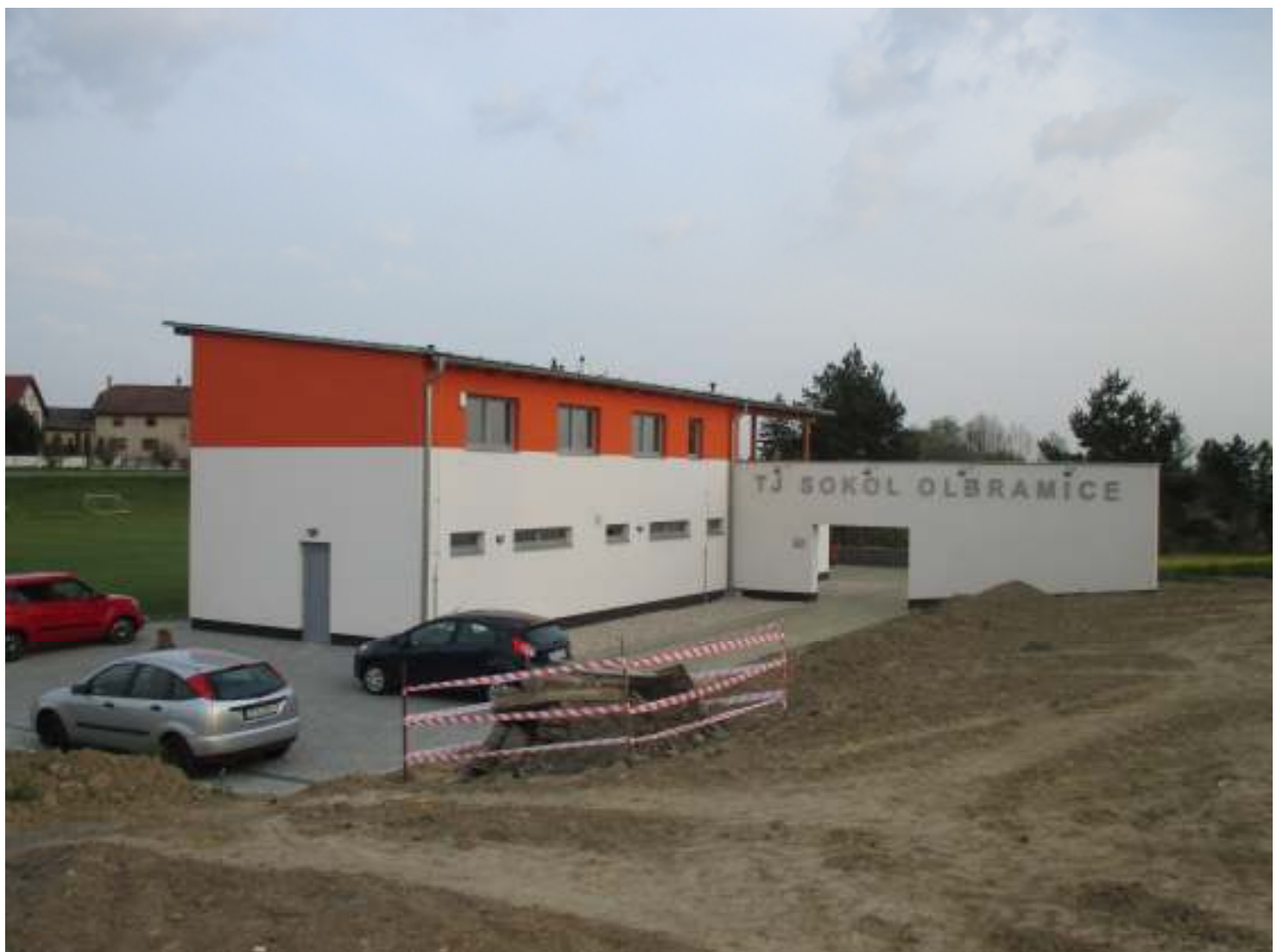
Pohled od cesty na zadní část budovy.
